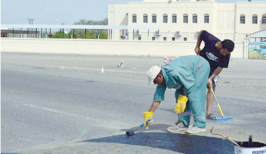
■ جانب من أعمال الطلاء
