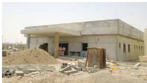
مبنى الطوارئ والحوادث بجعلان بني بوعلی
