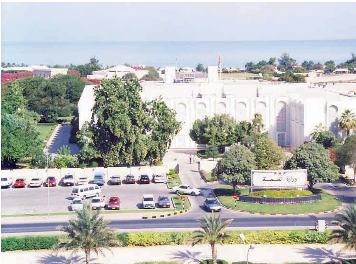
■ مبنى وزارة الصحة
