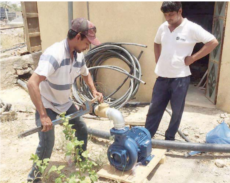
تركيب مضخات لرفع المياه لخزانات التوزيع
