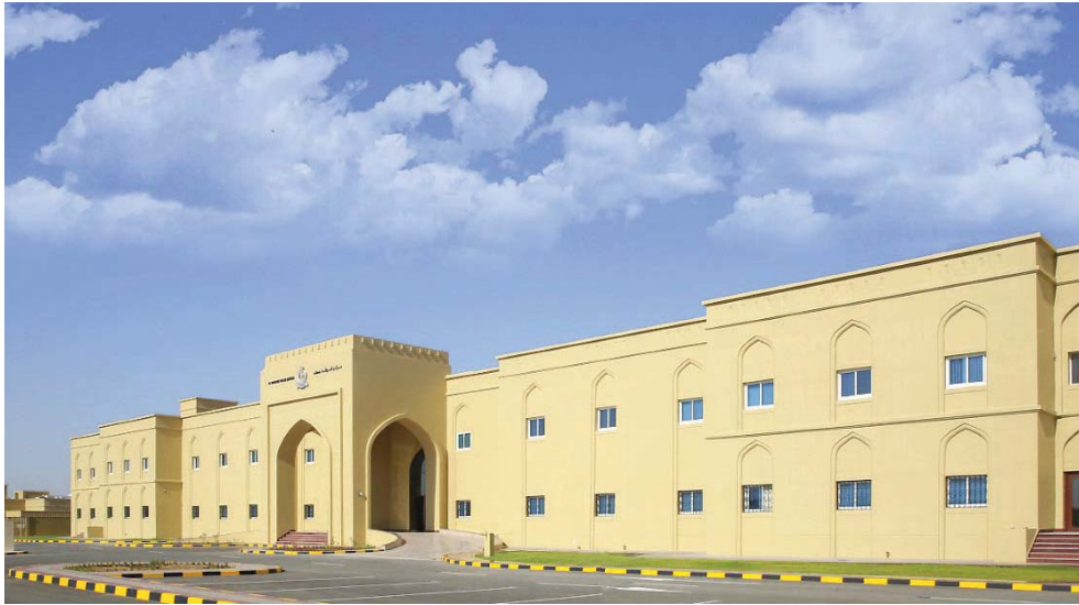
■ مبنى مركز شرطة
