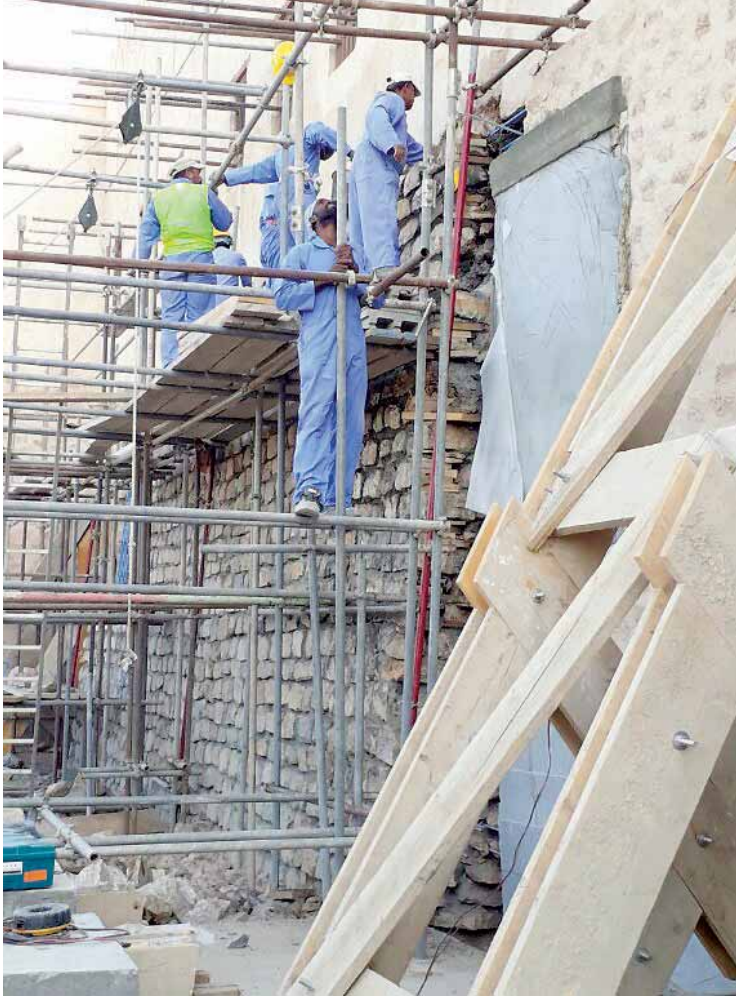
■ من أعمال ترميم حصن الخابورة
