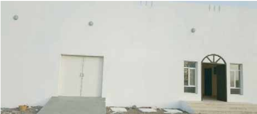
■ مبنى المسلخ من الخارج
