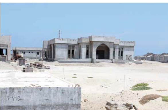
جانب من الخدمات قيد الإنشاء بجزر الحلايبات
