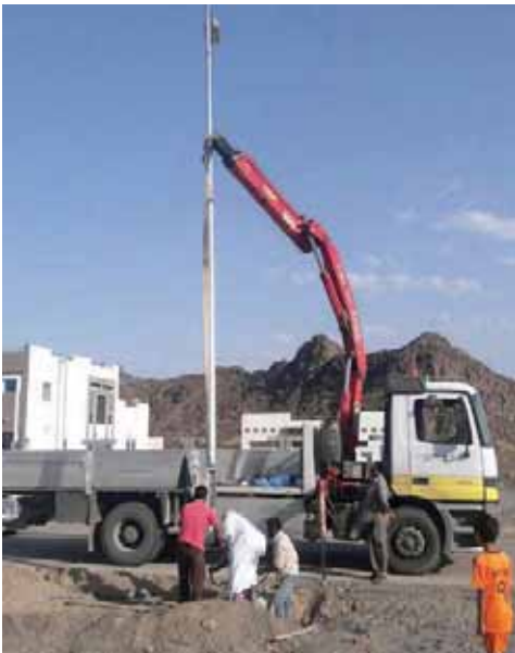
■ تركيب أعمدة الإنارة
