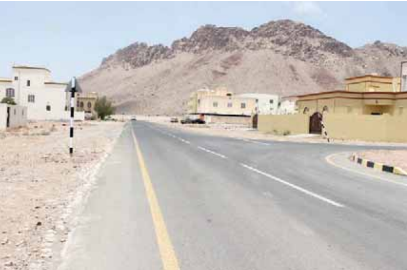
■ من أعمال الرصف
