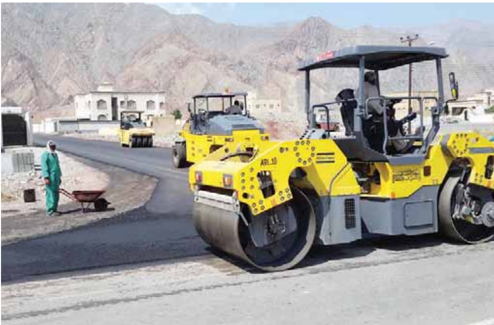
■ من أعمال الرصف
