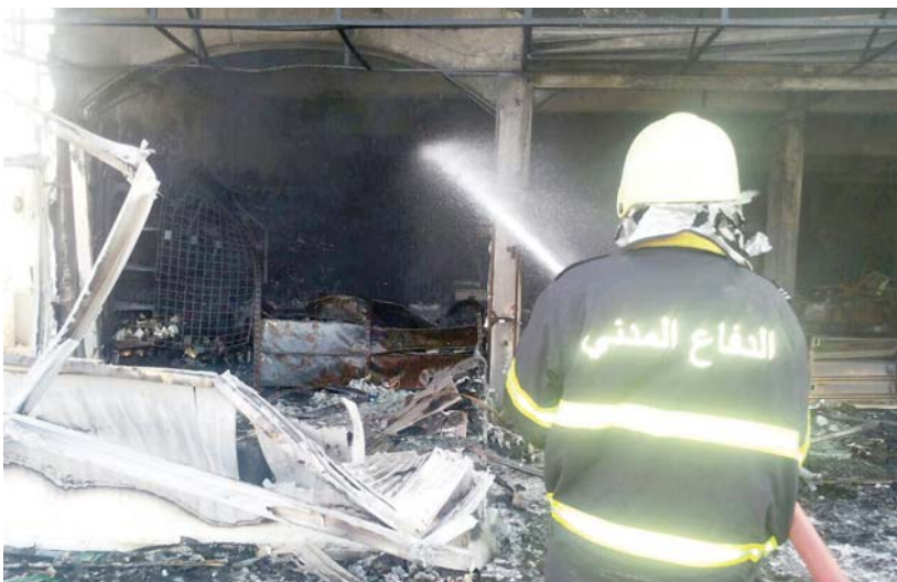
■ جهود رجال الدفاع المدني لإخماد الحريق
