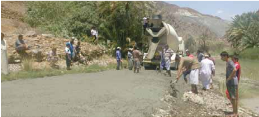
■ من أعمال رصف الطريق
