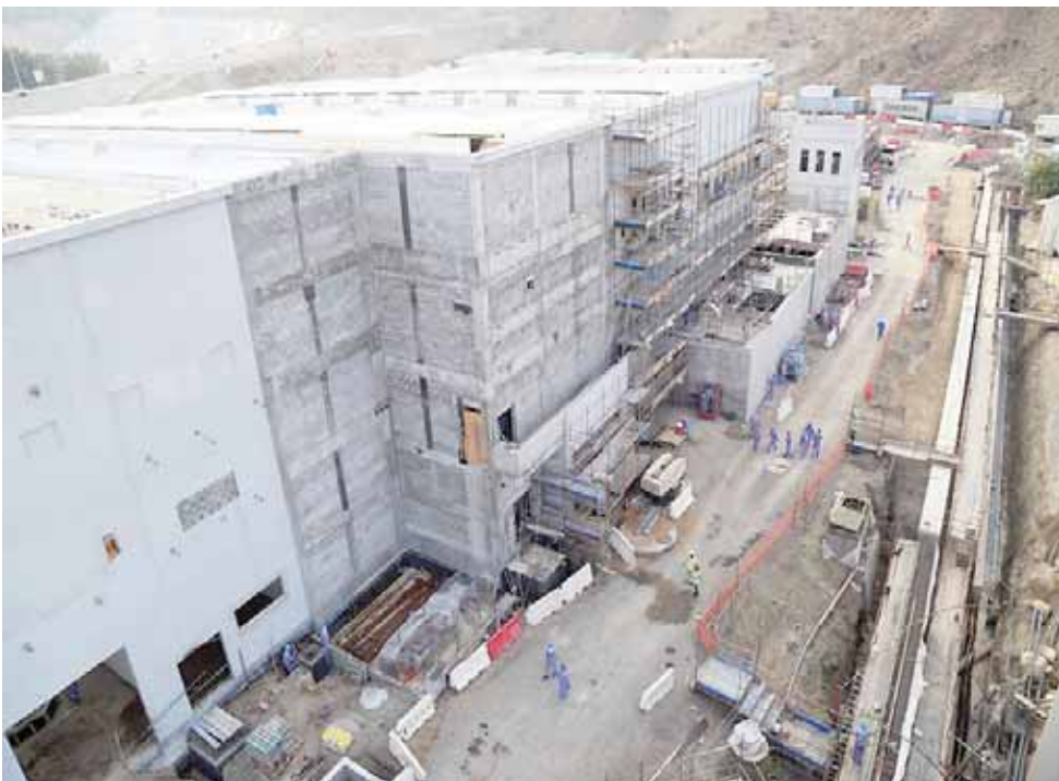
■ مبنى محطة الصرف الصحي بدارسيت
