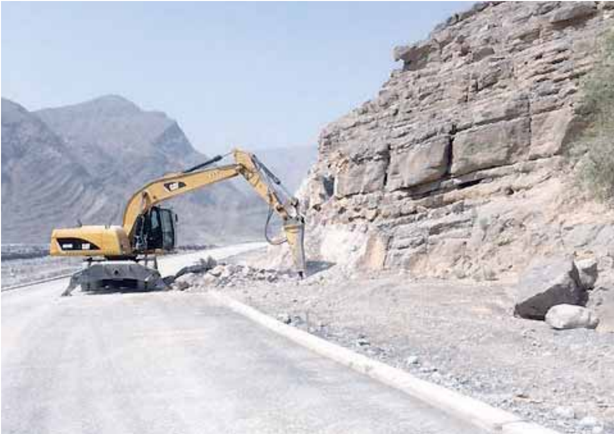
■ جانب من أعمال رصف الطرق
