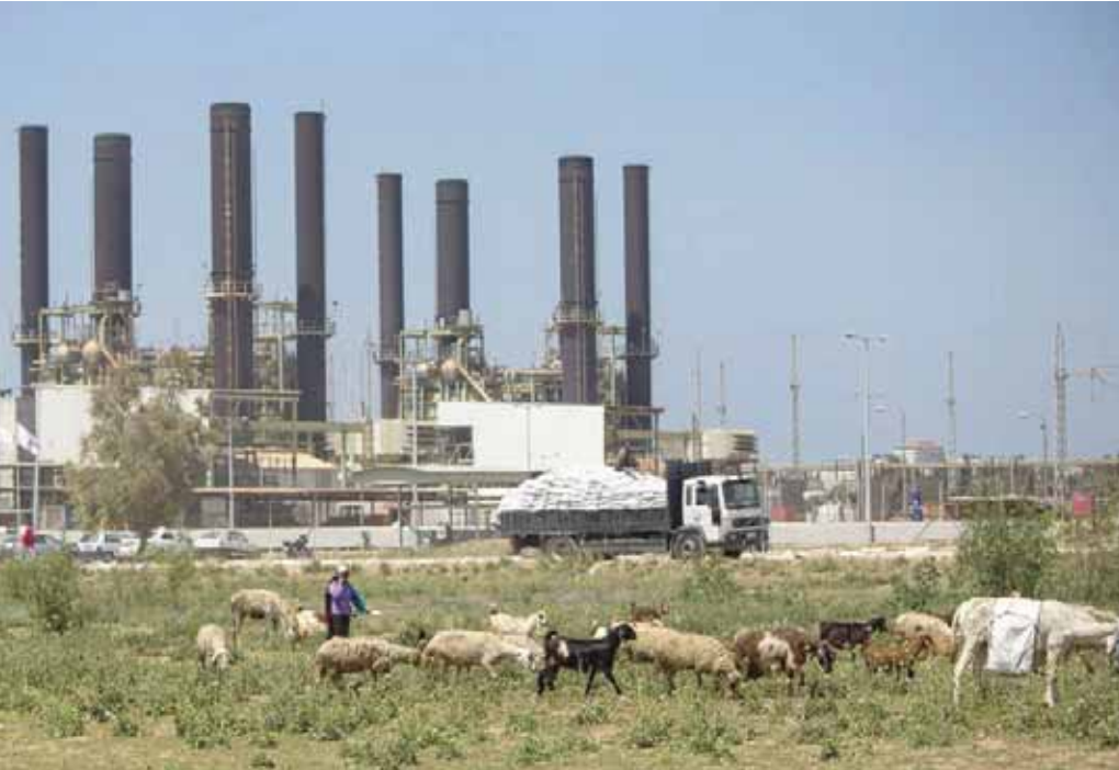
■ محطة توليد الكهرباء في غزة . (أف ب)
