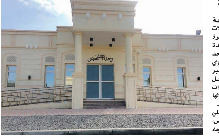
■ مبنى وحدة التشخيص
