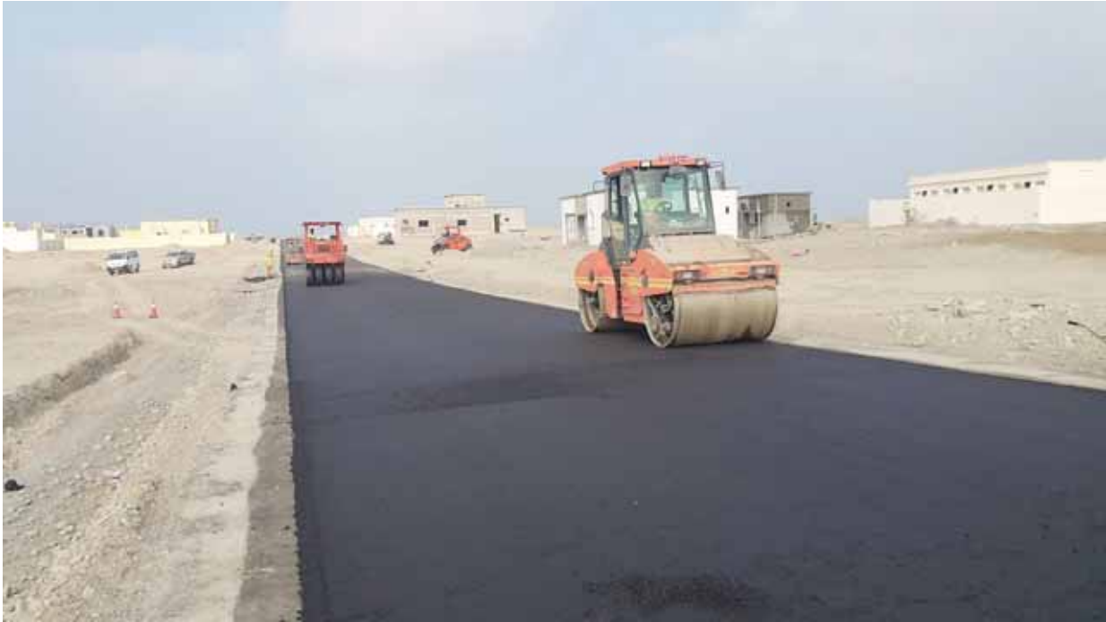
■رصف طريق بولاية مصيرة
