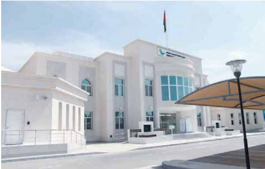
■ المبنى الجديد للهيئة العامة للكهرباء والمياه بولاية نزوى
