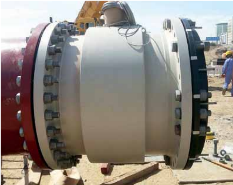
■ عداد حساب ضخ المياه الذي سيتم تركيبه في خط نقل المياه المغذي لمسقط
