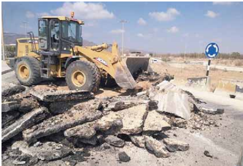
■ من أعمال إعادة تأهيل طريق إتين
