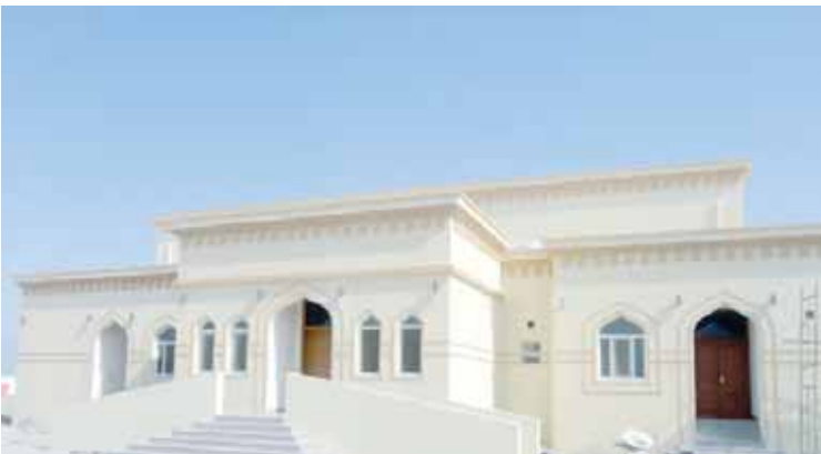
■ مبنى مسلخ مصيرة
