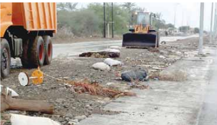
■ من أعمال بلديات شمال الباطنة
