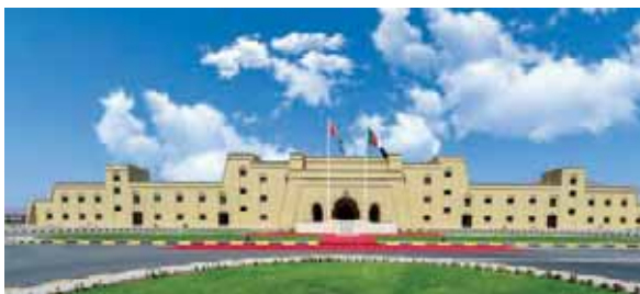
■ مبنى قيادة شرطة محافظة شمال الشرقية
