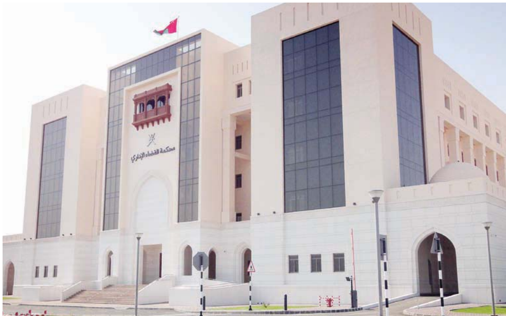
■ مبنى محكمة القضاء الإداري الجديد
