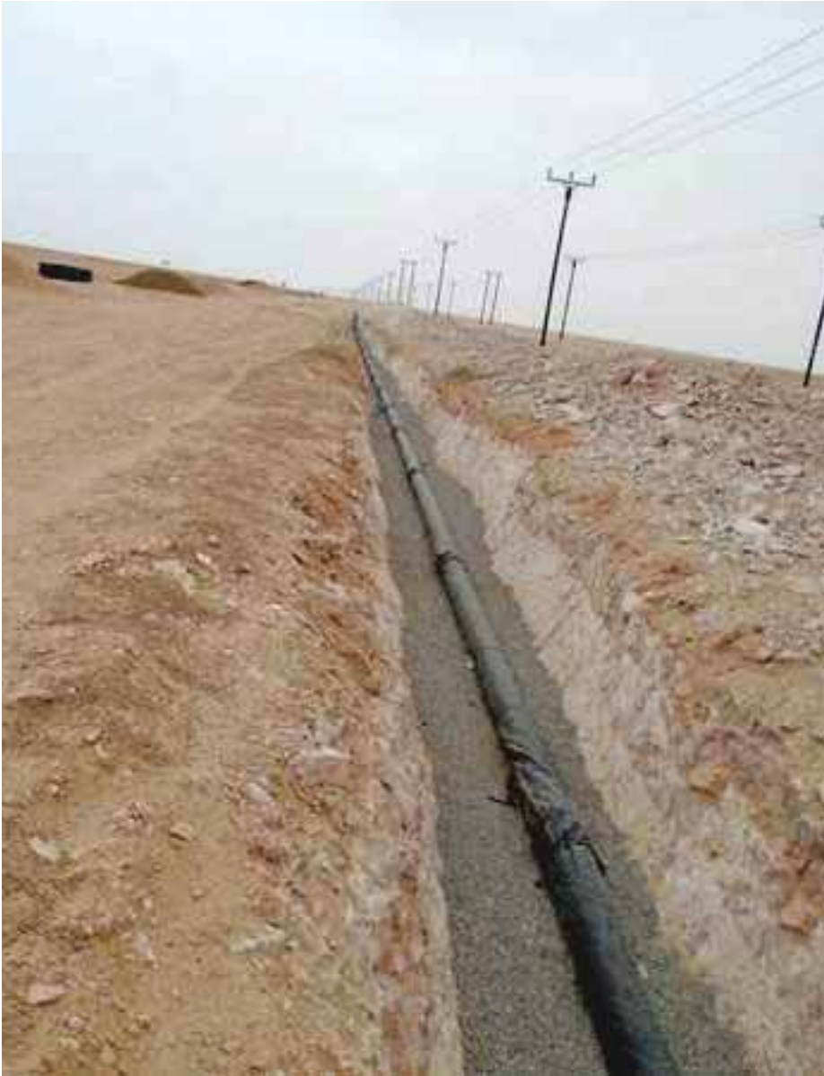
■ من مشاريع شبكات المياه
