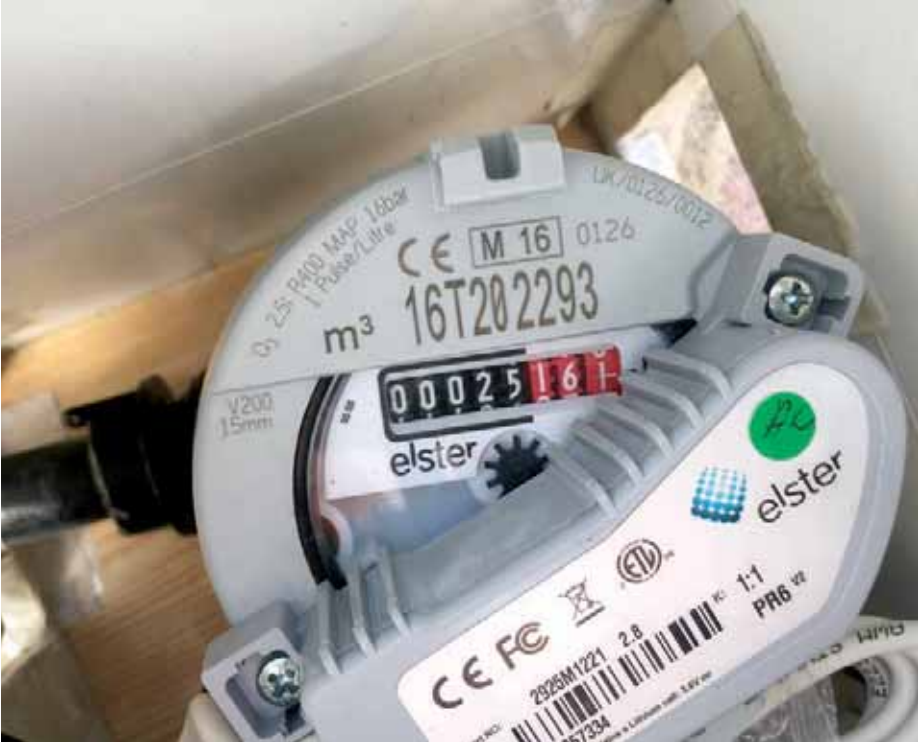
■ المحابس الإلكترونية التي تم تركيبها في خط النقل الجديد
