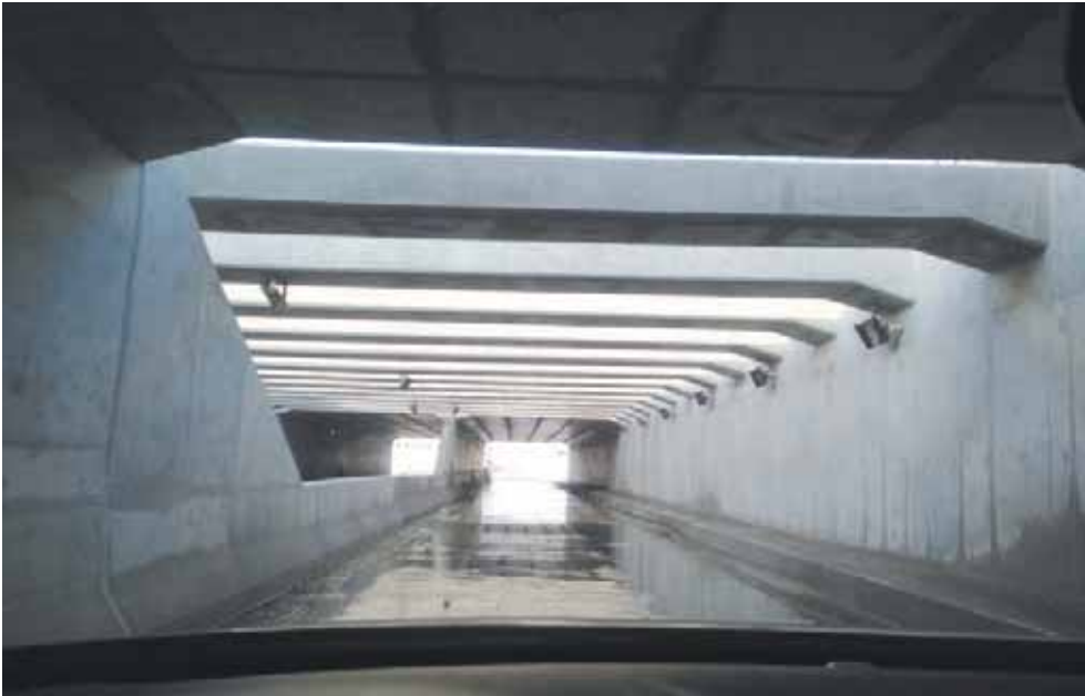
أحد معايير الأودية بتصميم جديد يراعي جريان المياه ويستخدم ممرا لعبور المركبات في آن واحد
