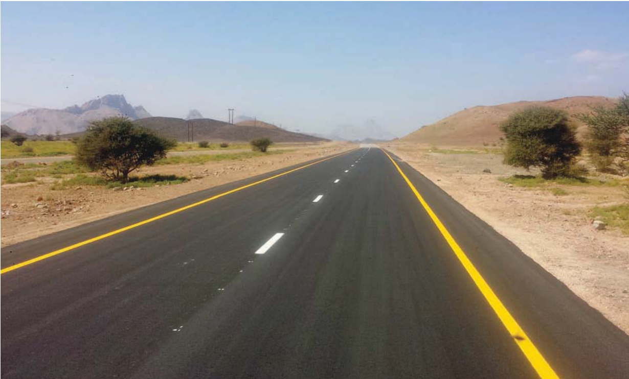
■ جانب من رصف الطرق الداخلية
