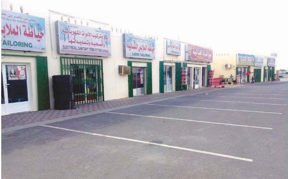
■ من أعمال رصف الطرق
