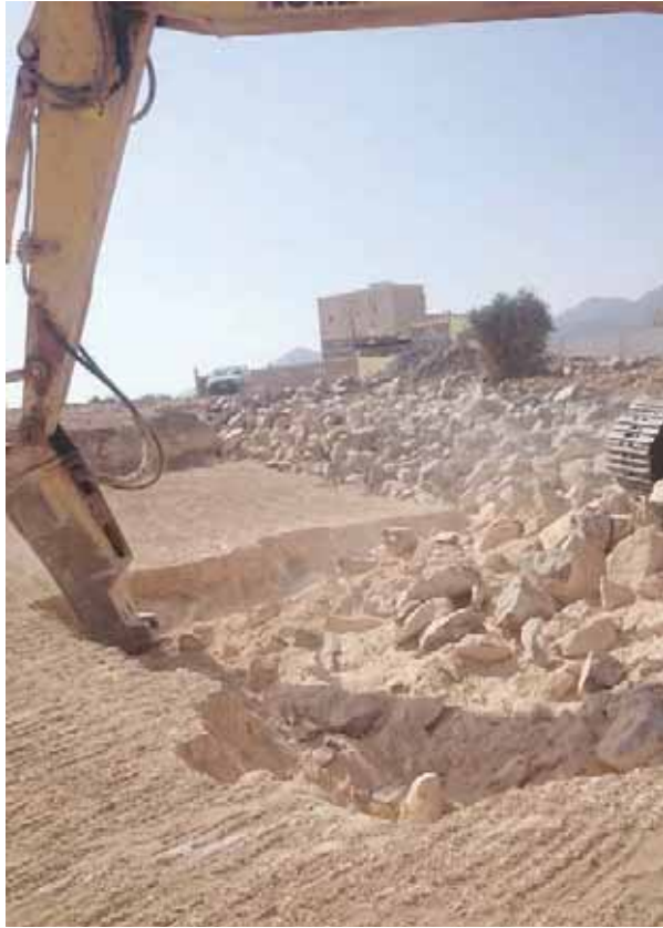
جانب من أعمال الحفريات
