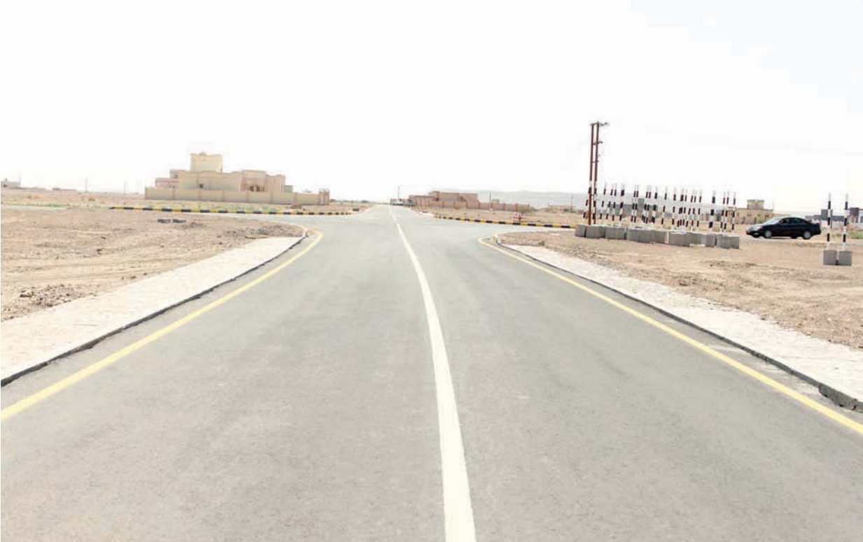
من مشاريع رصف الطرق
