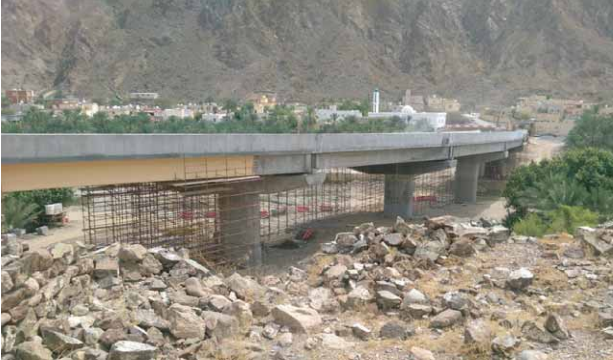
مشروع إنشاء جسر وادي بني هني
