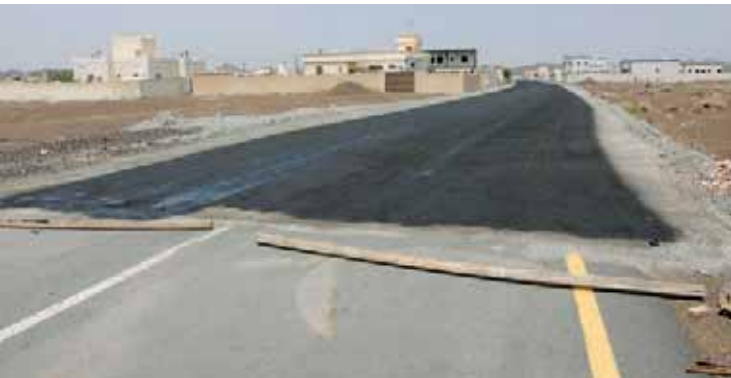
جانب من رصف الطرق الداخلية
