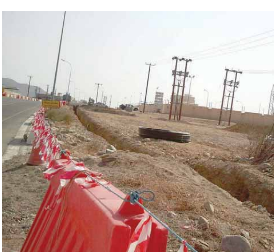
جانب من أعمال المشروع
