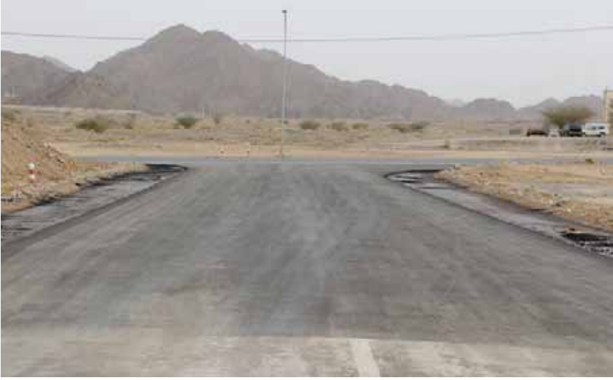
جانب من رصف الطرق
