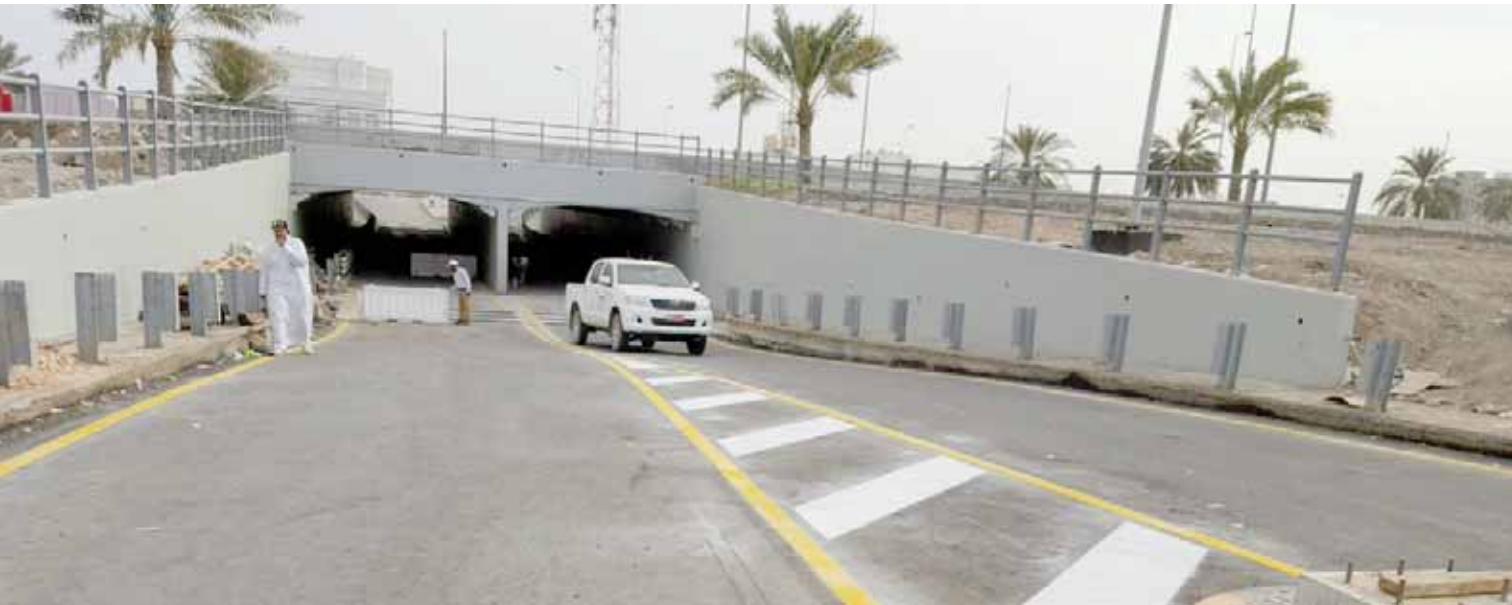
جانب من النفق الذي يربط المعبيلة الشمالية بالجنوبية
