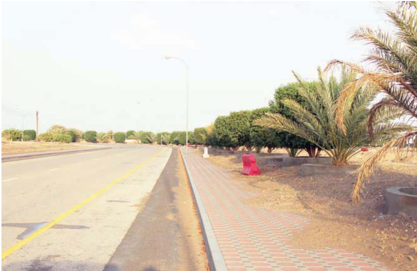
رصف الطرق الداخلية
