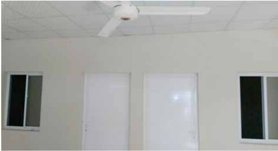
المنزل من الداخل بعد الترميم
