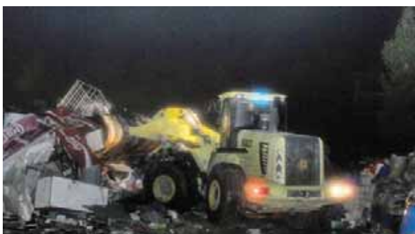
أنشاء عمليات مكافحة الحريق
