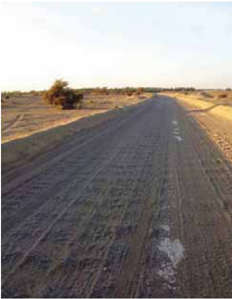
■ من أعمال رصف وسفلتة الطرق الداخلية
