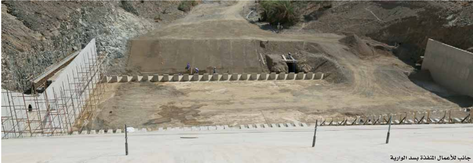
جانب للأعمال المنفذة بسد الوارية
