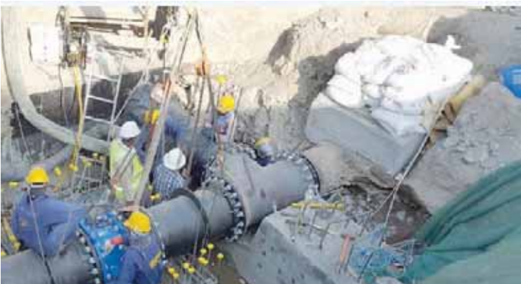
من أعمال الربط لخزان مسقط الجديد
