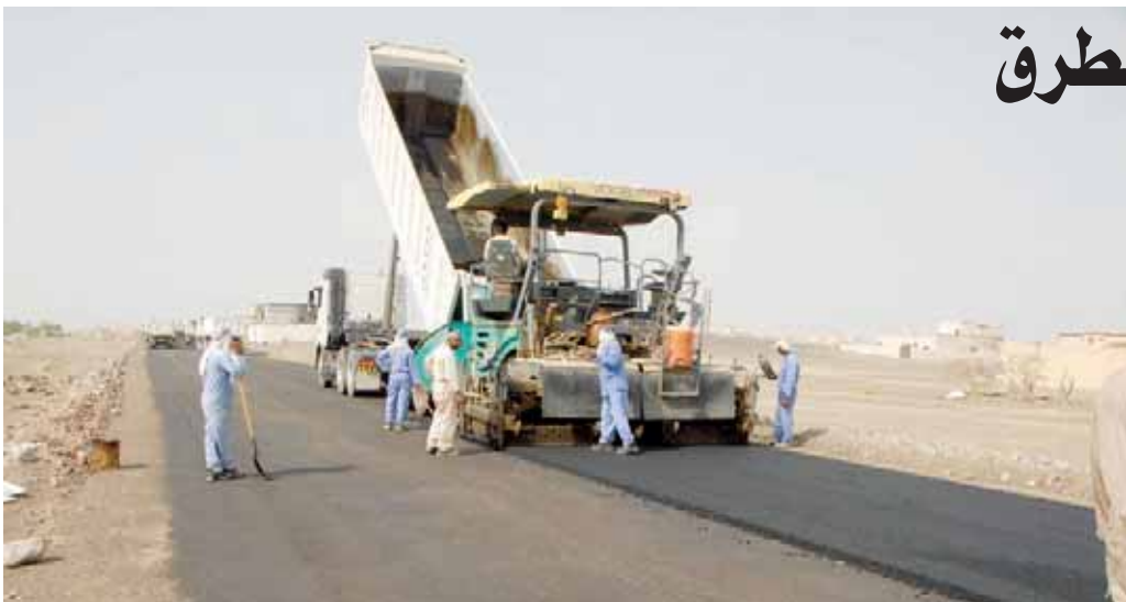
جانب من رصف الطرق الداخلية بالمضيبي
