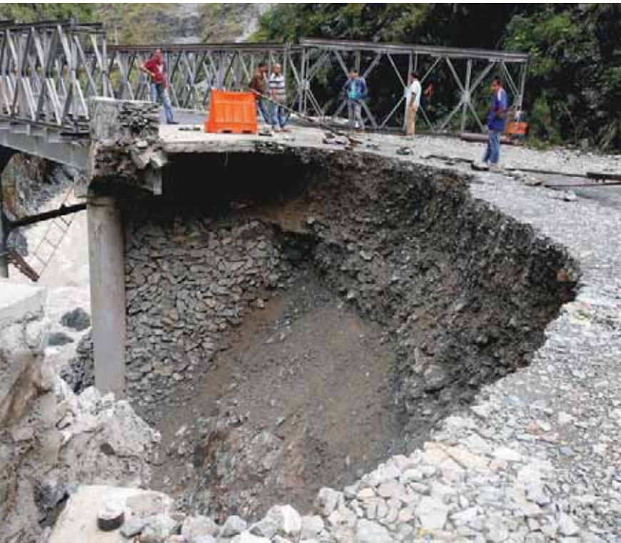
جسر تعرض للجرف بسبب الفيضانات المصاحبة للإعصار في الضلبين
