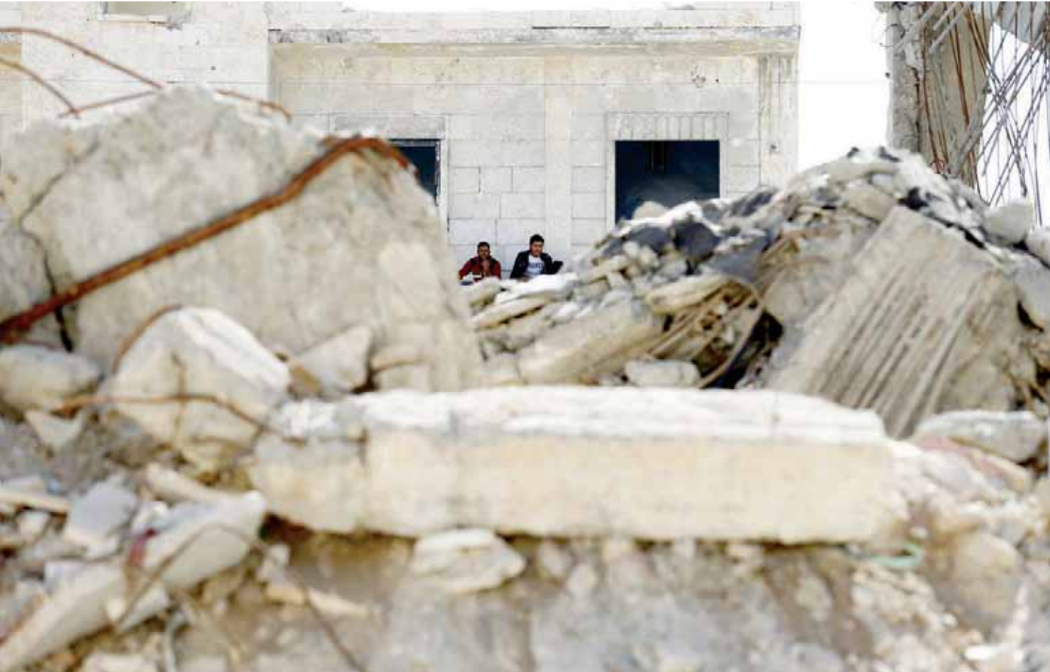
مبنى مدمر في بلدة حدودية سورية نتيجة القصف الجوي ويظهر خلفه رجلان جالسان.
