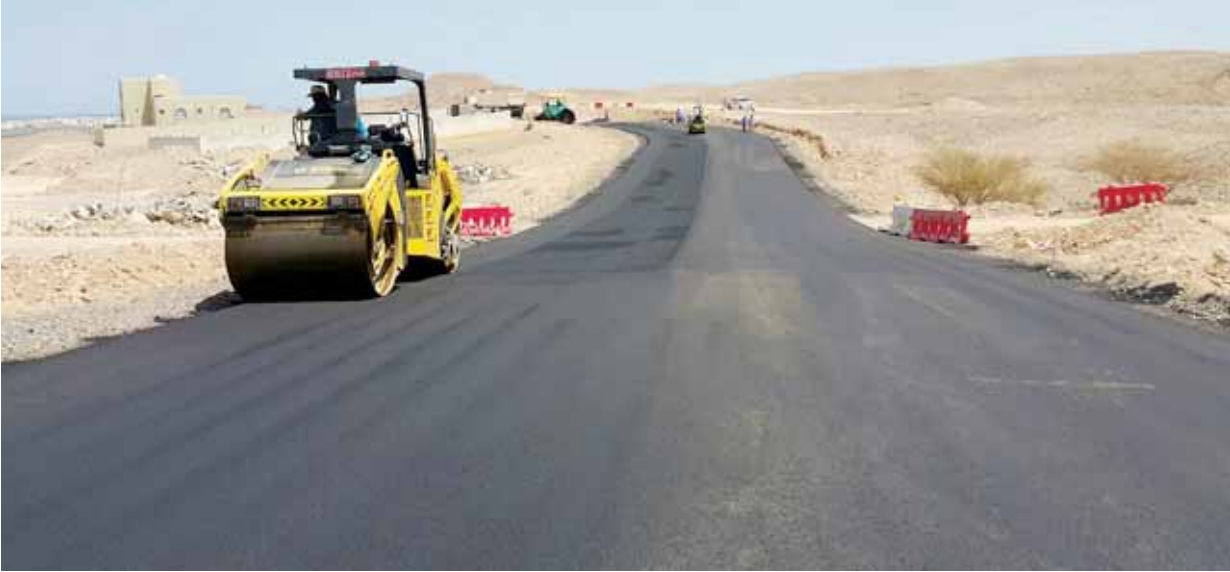
رصف الطرق بجنوب الشرقية
