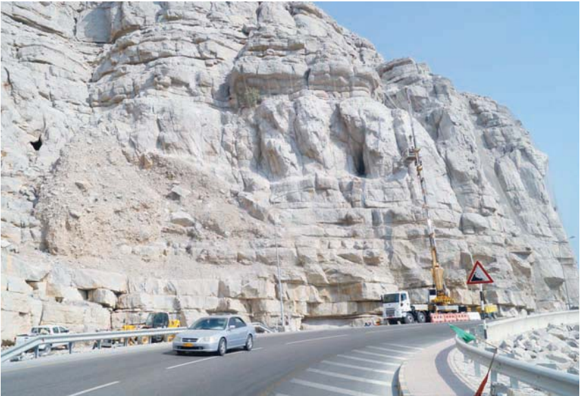
من أعمال رصف الطرق
