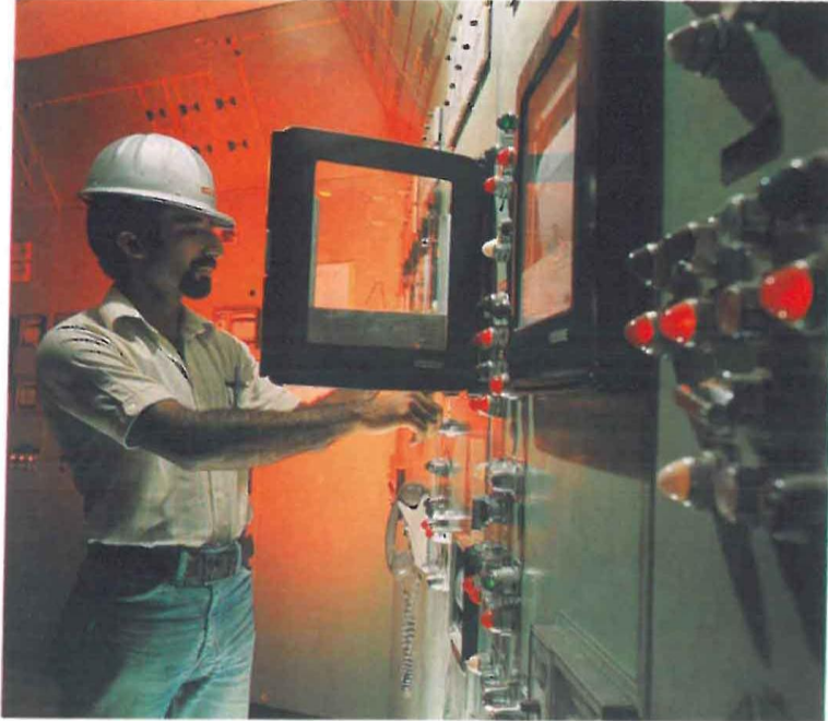
مركز المراقبة للنفط بميناء الفحل
