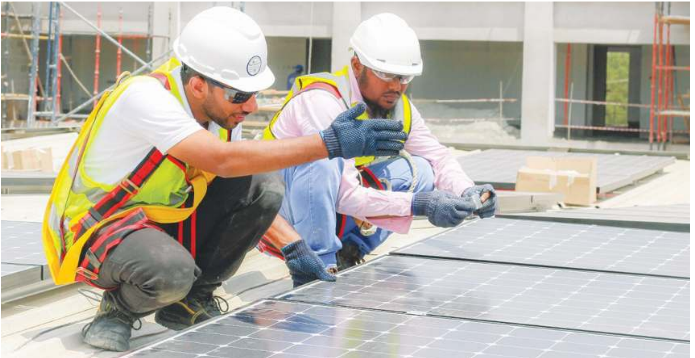
شركة «نفاذ» العمانية خلال تركيب ألواح شمسية لأحد المباني
