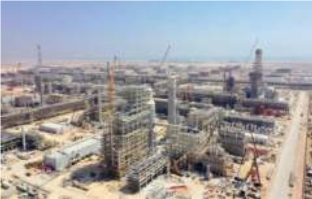
■ تمّ حتى نهاية مارس الماضي استخدام ٤٠٤٠٦ ألف متر مكعب من الخرسانات في مشروع مصفاة الدقم و٥٥١ ألف طن من القواعد الفولاذية، وسُجِّل المشروع ١٠٦٢ مليون ساعة عمل.
