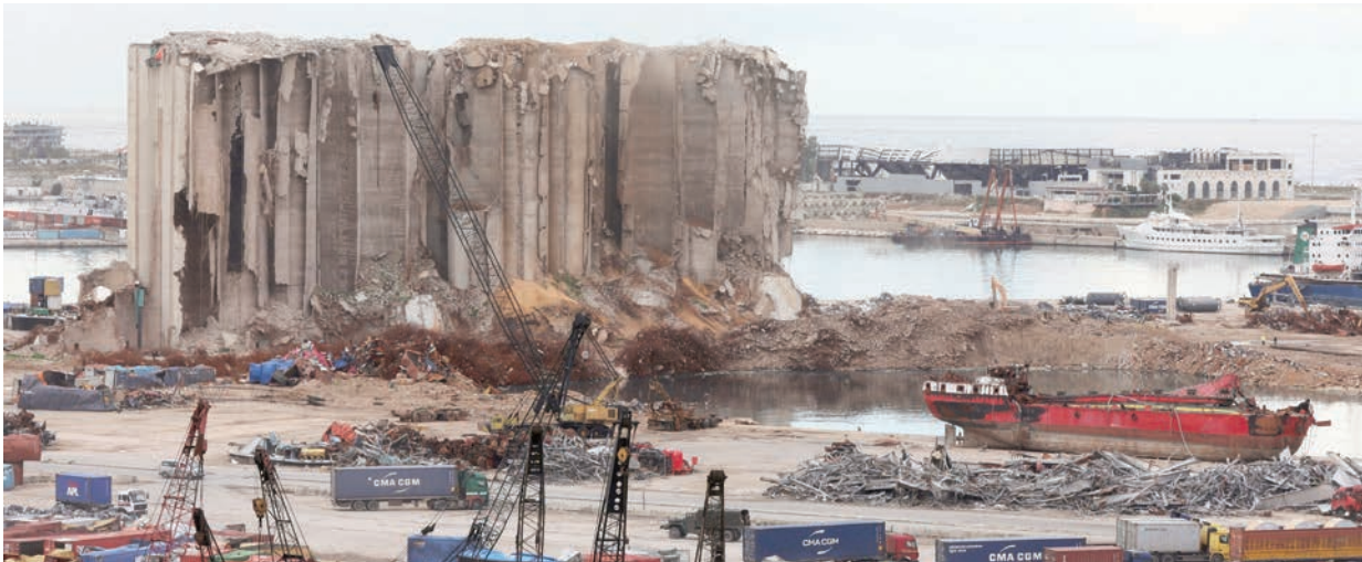
■ صورة تظهر موقع انفجار ٤ أغسطس في مرفأ بيروت.
