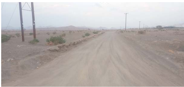
تكملة رصف الطريق يسهل عملية الحركة المرورية
