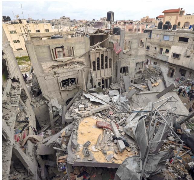
د. ف. ب. ■ أنقاض مبنى دمره القصف الإسرائيلي على رفح.
