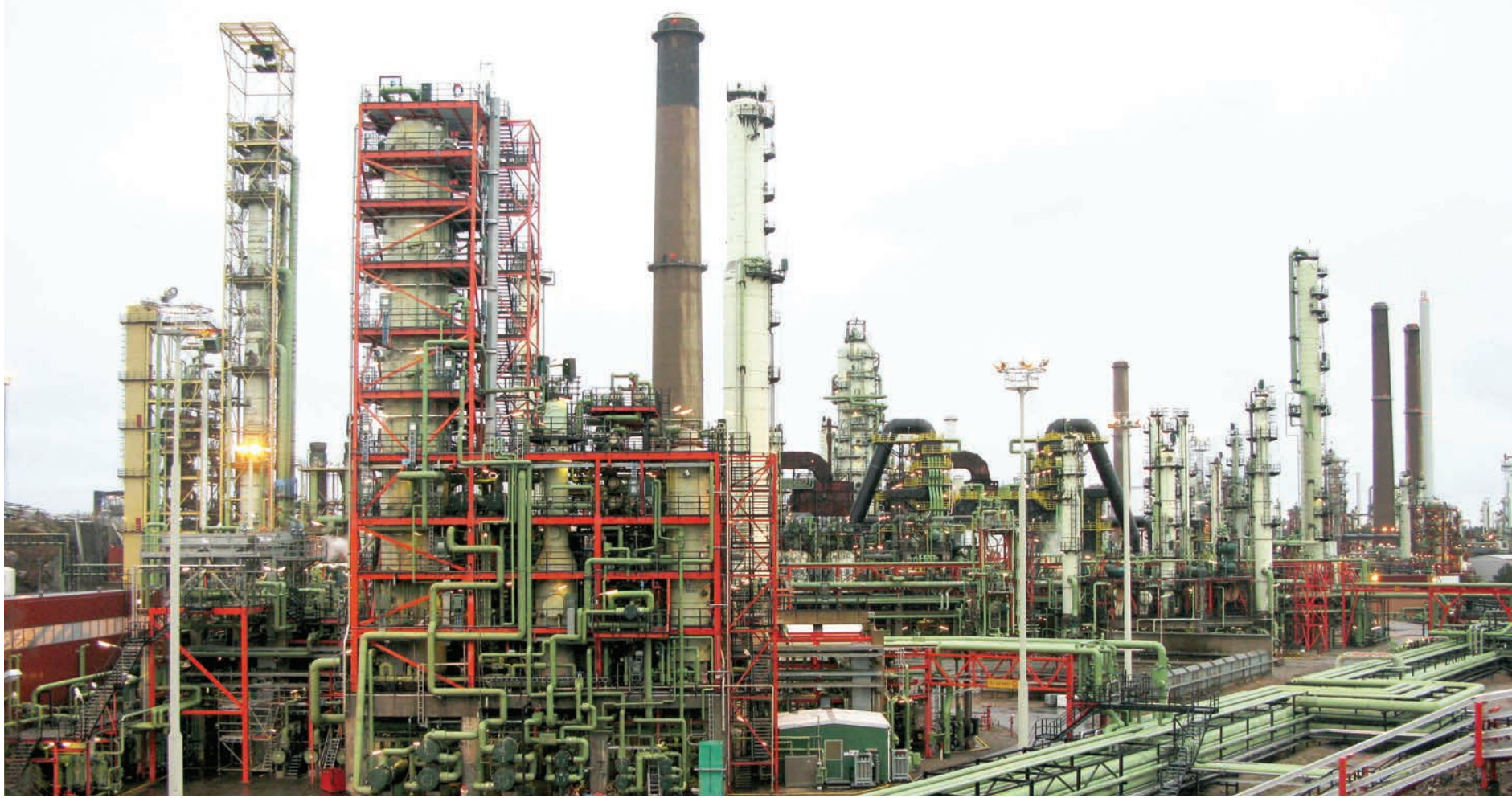
مصفاة نفط نيسبي- بطاقة تكرير إجمالية تبلغ حوالي ١٢,٥ مليون طن سنويا- في بورفو جنوب فنلندا.
