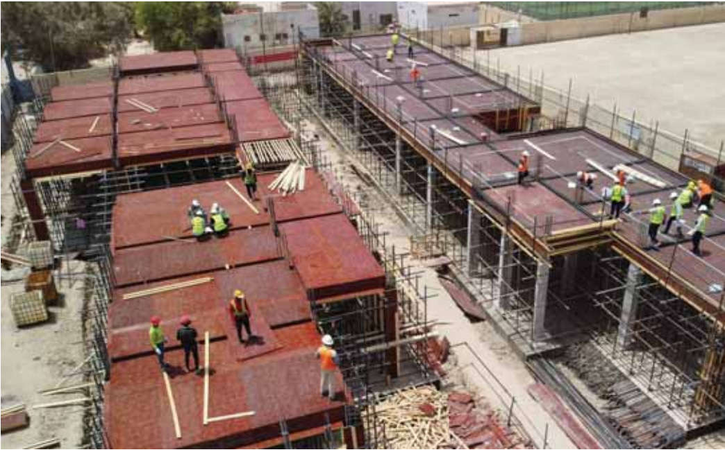
■ عمال يعملون في موقع بناء مدرسة كجزء من صفقة "النفط مقابل البناء" بين العراق والصين في حي سومر بمدينة الناصرية بمحافظة ذي قار جنوب العراق. ا. ف. ب
